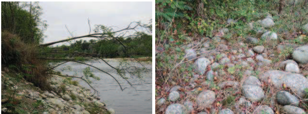
Foto 56-57. La difesa spondale a ciottoli e particolare della matrice grossolana. E' praticamente assente la matrice fine (sabbia).
